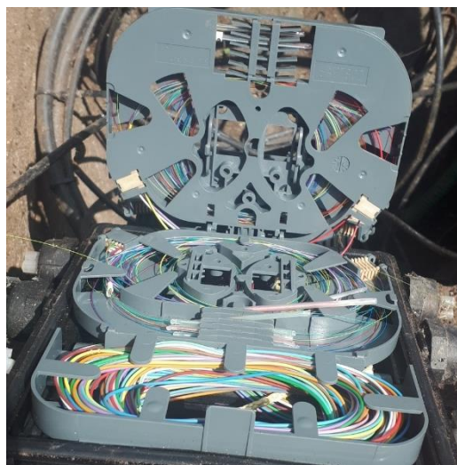
Figure 5 : Point de Branchement en chambre
